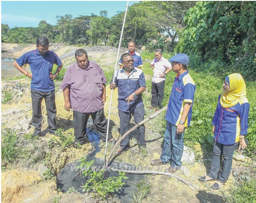
Azman (dua dari kanan) dan Kalithasan (tiga dari kanan) meninjau kawasan kebocoran paip saluran kumbahan yang mengakibatkan pencemaran kolam takungan banjir di Taman Desa Mewah, Semenyih, Kajang semalam.
